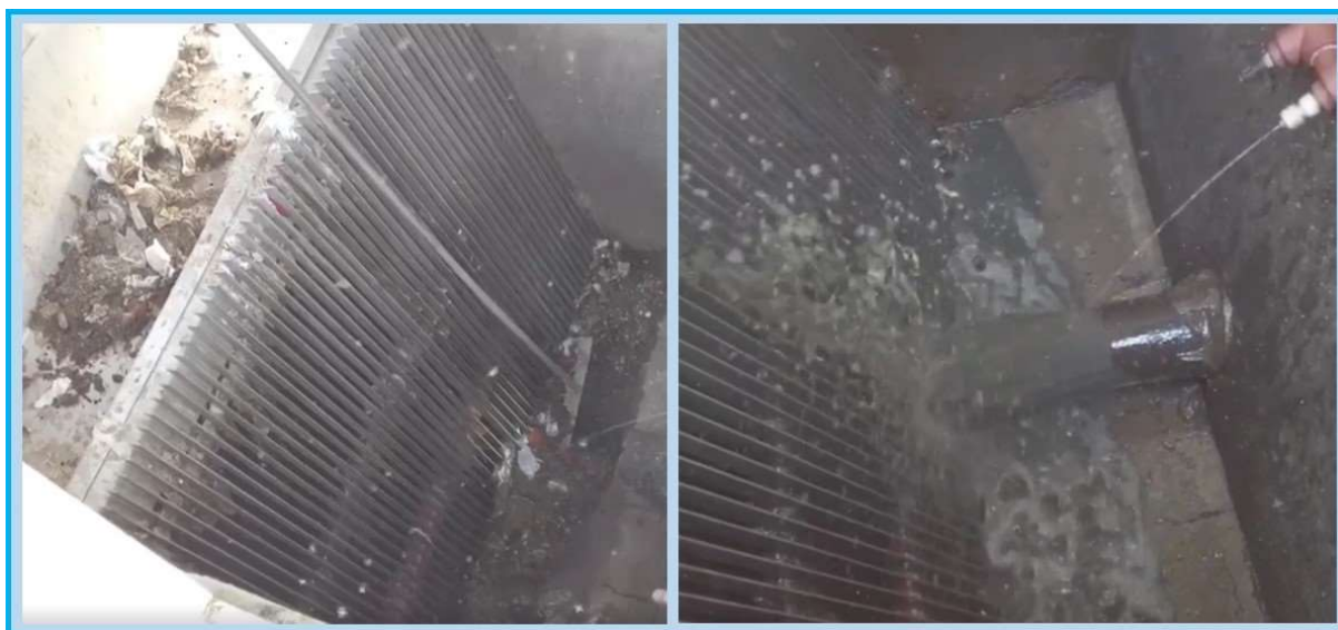
Figura 7: Dos vistas de las rejillas empleadas para la remoción de sólidos groseros
